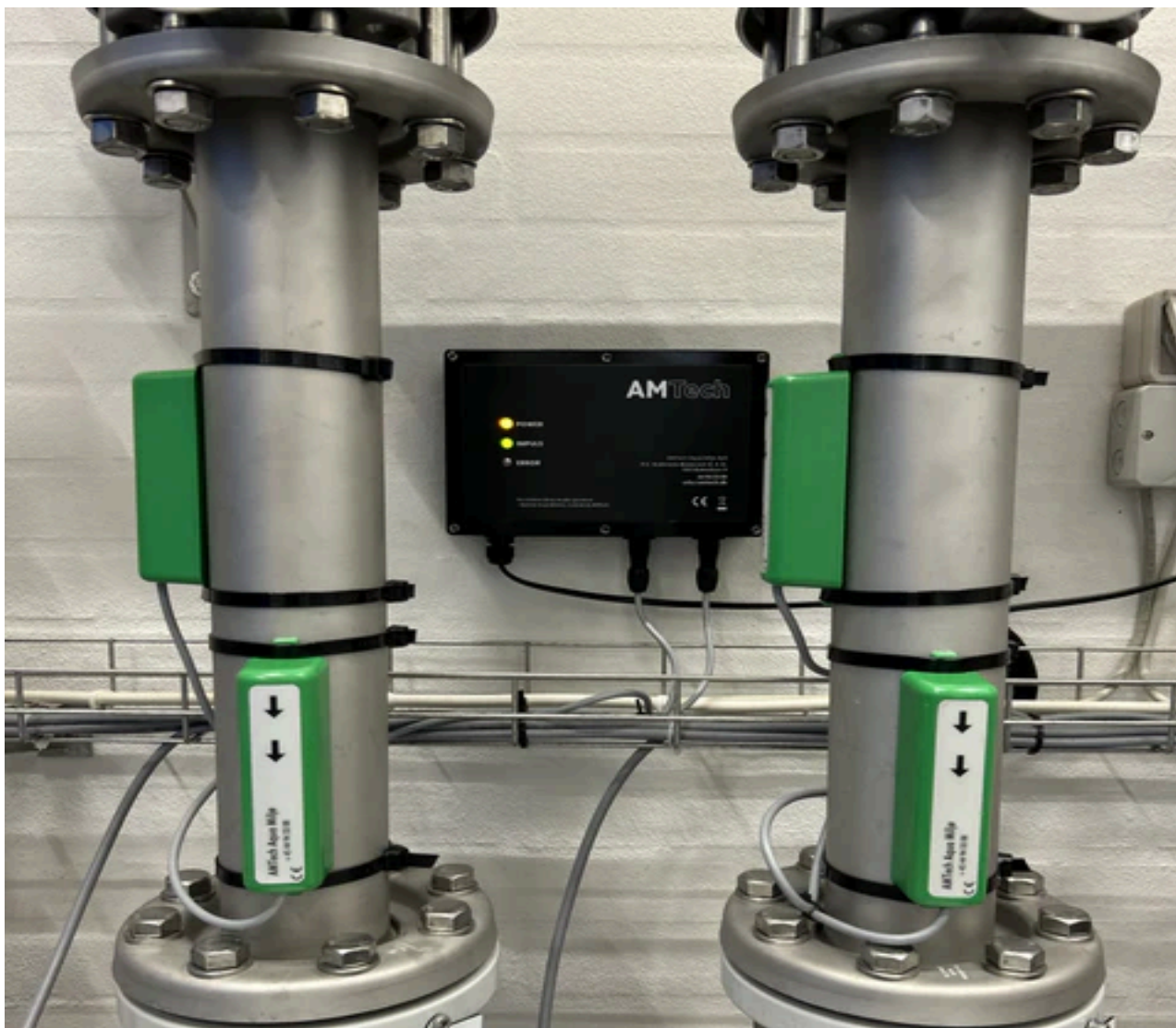
Abb. 7: AMTech 700 mit zwei Emittierköpfen und separater Elektronikeinheit. Dieses Modell stammt aus der Zeit vor AMTech 100. Das Elektronik-Steuergerät wurde nicht geöffnet, um das geistige Eigentum des Unternehmens zu schützen.
